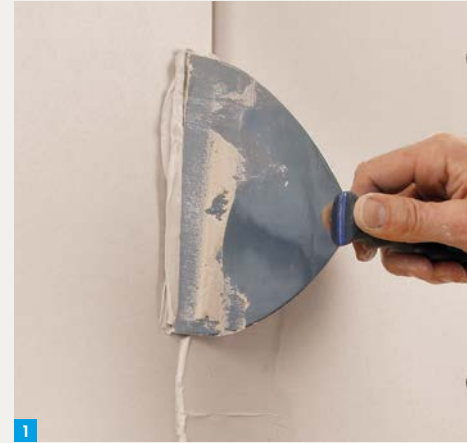
1. Knauf Uniflott in die Gipsplattenfuge einbringen.
