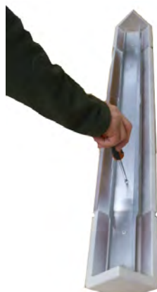
Fig. 26 - Das Profil an den Majoliken anschrauben
