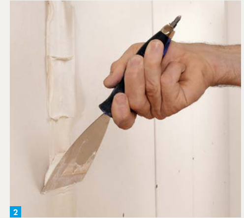
2. Mit dem Schraubgriffspachtel scharf abziehen.
